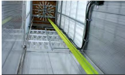
Druckschläuche gehören getrocknet, dafür steht der Schlauchturm zur Verfügung
